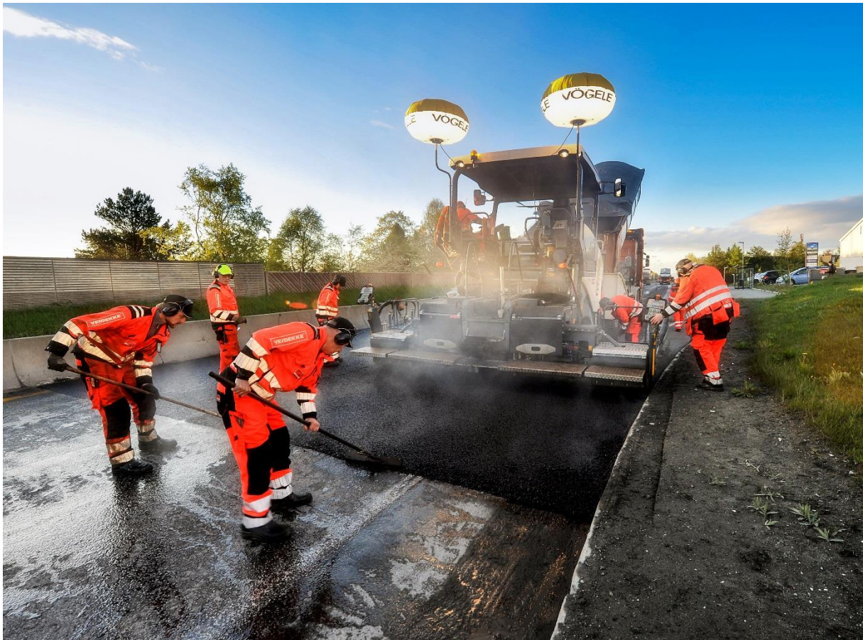
Asfaltering av E6 ved Trondheim. Foto: Knut Opeide
