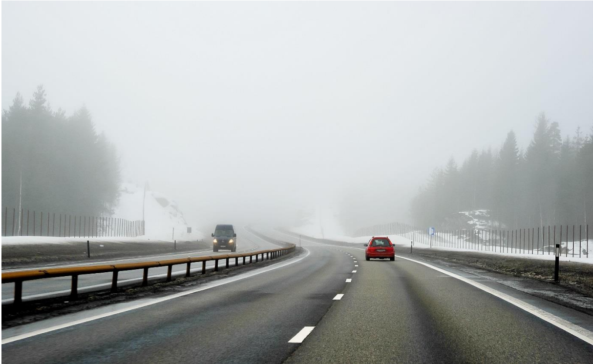
Midtrekkverk på E6 ved Dal i Akershus. Foto: Knut Opeide
