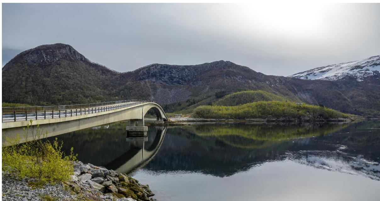
Sandhornbrua ved fylkesveg 17. Foto: Steinar Skaar
